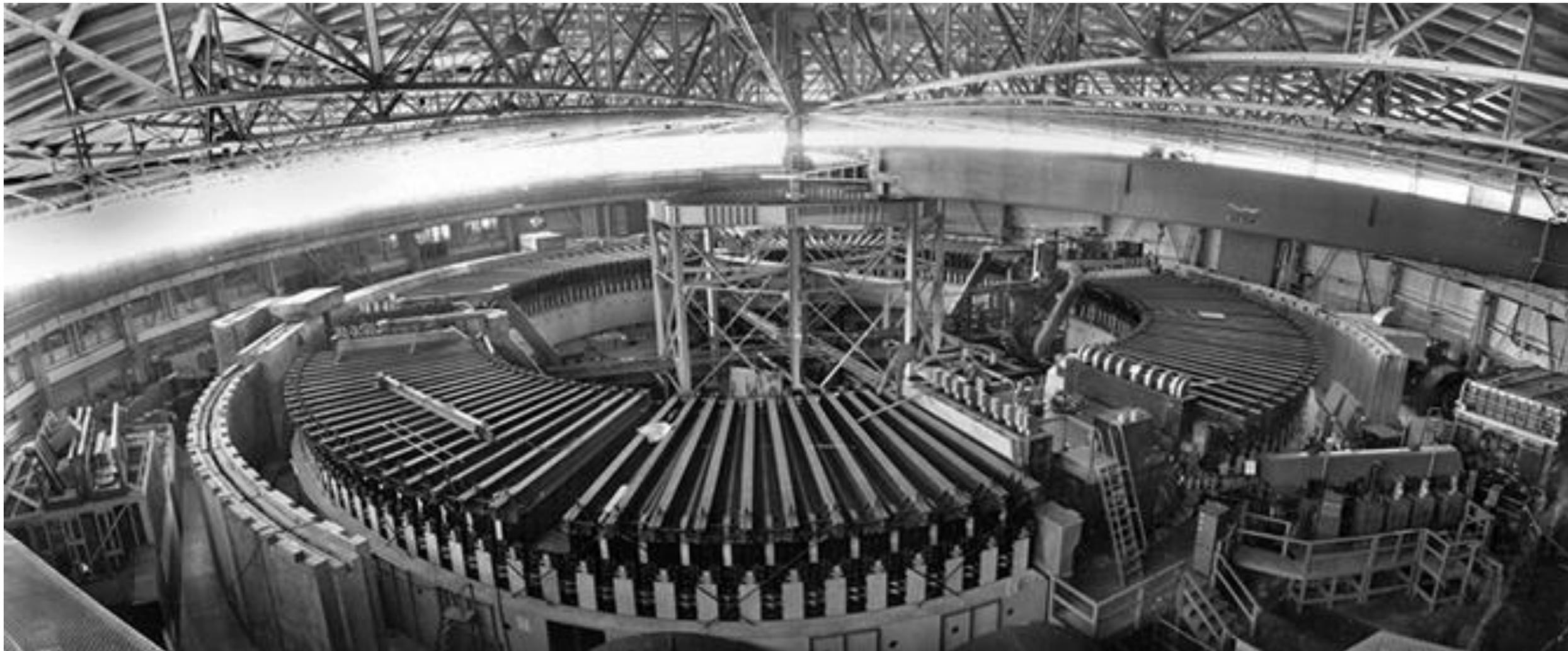
**Il Bevatrone di Berkeley. Nel 1955 era l'unica macchina al mondo in grado di accelerare un fascio di protoni all'energia di 6.3 GeV, superiore all'energia di soglia per la produzione di coppie protoni-antiprotoni.**
