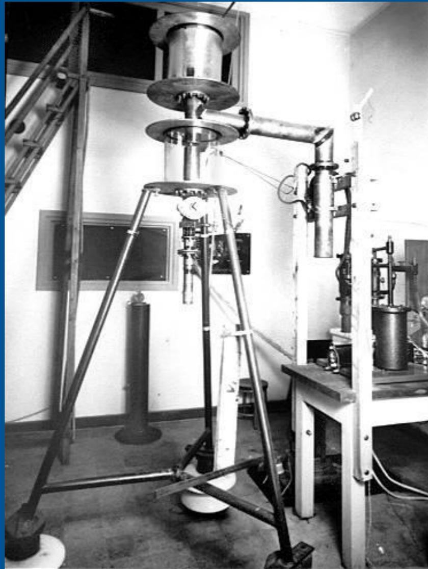
Nel 1936 Amaldi, Fermi e Rasetti costruiscono un piccolo acceleratore elettrostatico (la prima macchina acceleratrice italiana)
